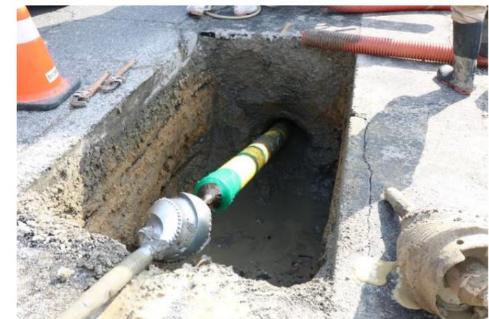
先導削孔工（パイロット削孔工）とロケーティング状況
